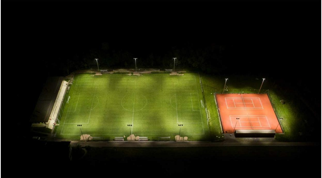
Das Drohnenfoto zeigt die komplette Beleuchtung in Betrieb. Nur dank dem Einsatz modernster asymmetrischer Scheinwerfer mit interner Blende ist es möglich, dass das in die Umgebung abgestrahlte Licht auf ein Minimum reduziert wird und damit die Vorgaben des Kantons Zug sehr gut erfüllt werden.
