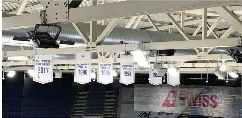
Die erforderliche Leistung inklusive Betriebsgeräten beträgt bei 100%-Betrieb 60 kW (48x 1250 W). Gegenüber der alten Beleuchtung (52x 1065 W = 55.4 kW inkl. Betriebsgeräten + 12x 2080 W = 25 kW inkl. Betriebsgeräten) können somit ca. 20.3 kW oder 25% eingespart werden. Zusätzliche Einsparungen ergeben sich mittels Schaltstufen mit niedrigeren Beleuchtungswerten.
